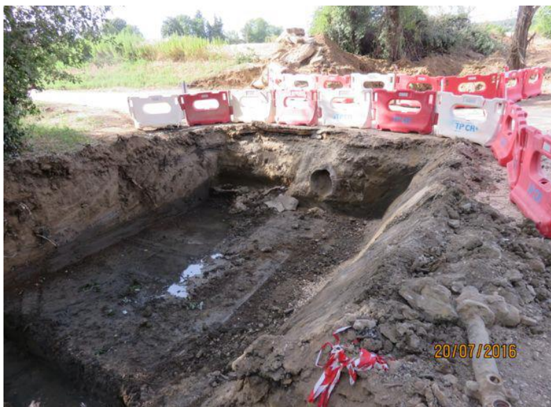
Réalisation d'un pont au Carrefour Massillargues – La Garonne
