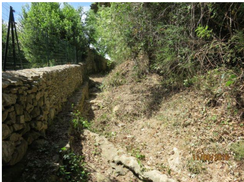
Remise en état du chemin des Couleuvres
