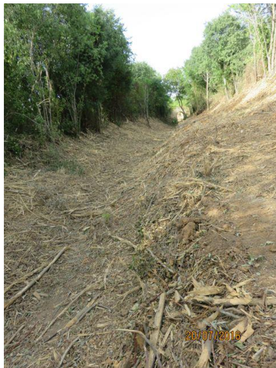
Nettoyage du Valadas
